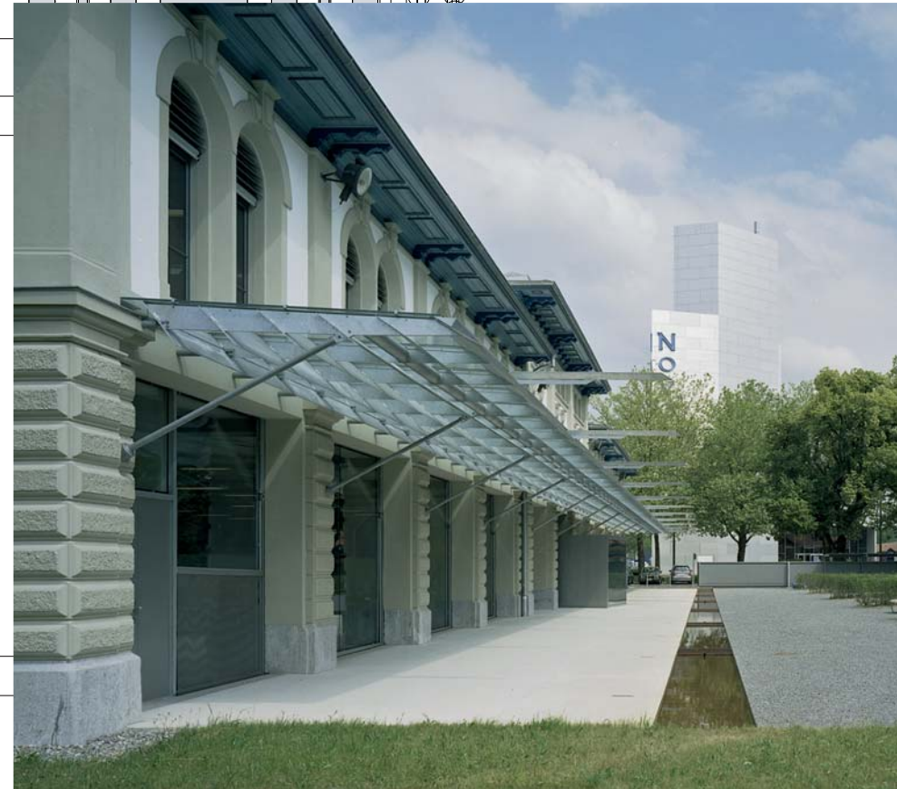
Zugang unter Vordach entlang Südfassade
