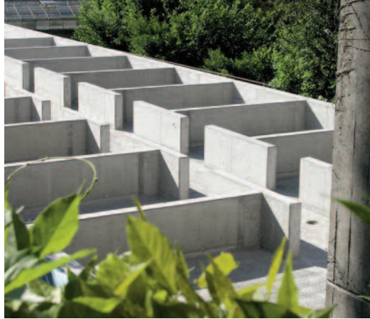
Kabineneinteilung im Rohbau
