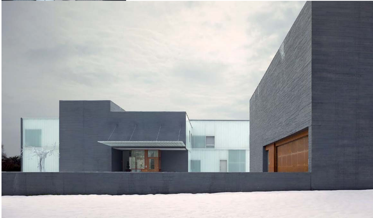
Ansicht von Norden
