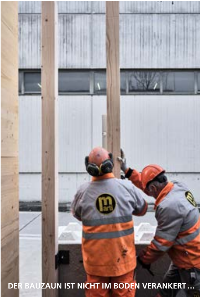
... ER IST MIT GEWICHTEN AUS BETON GESICHERT
